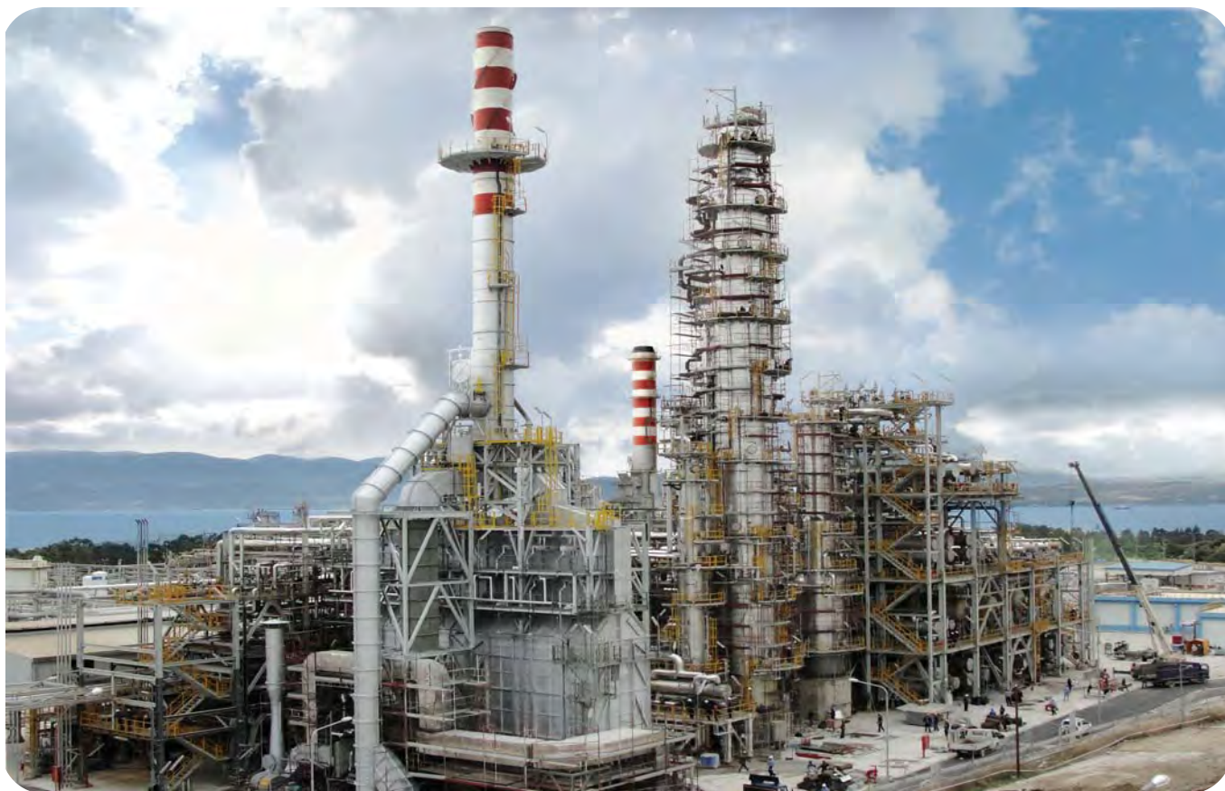
Άποψη της νέας μονάδας Ατμοσφαιρικής Απόσταξης στο τελικό στάδιο κατασκευής.
